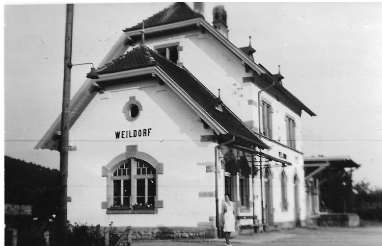
Abbildung 11 Haltestation Weildorf mit Güterhallenanbau (Bild aus den 1940er Jahren, im Vordergrund Anneliese Kasnitz, geb. Kaltenbach)
