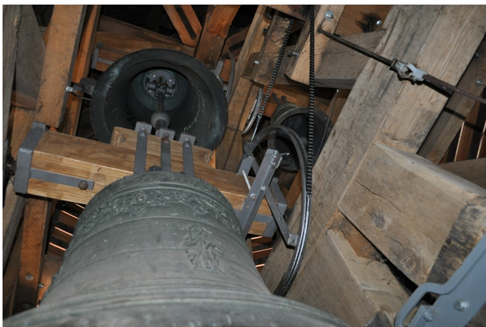
Abbildung 24 Blick in den Glockenstuhl, unten die älteste und größte Glocke, die Dreifaltigkeitsglocke, aus der Salemer Gießerei F. Koch; darüber die Ave-Maria-Glocke aus der Gießerei Rosenlächer, Konstanz
