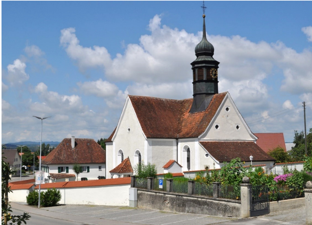
Abbildung 1: Heutige Südost-Ansicht der Weildorfer Pfarrkirche St. Peter und Paul. Links dahinter das erste Weildorfer Schulhaus, das 1793 im Auftrag von Kloster Salem unter Abt Robert Schlecht gebaut wurde.
