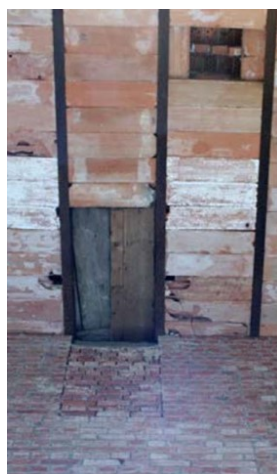
Abbildung 4: Noch vorhandene Lüftungselemente (Stand 2013)
