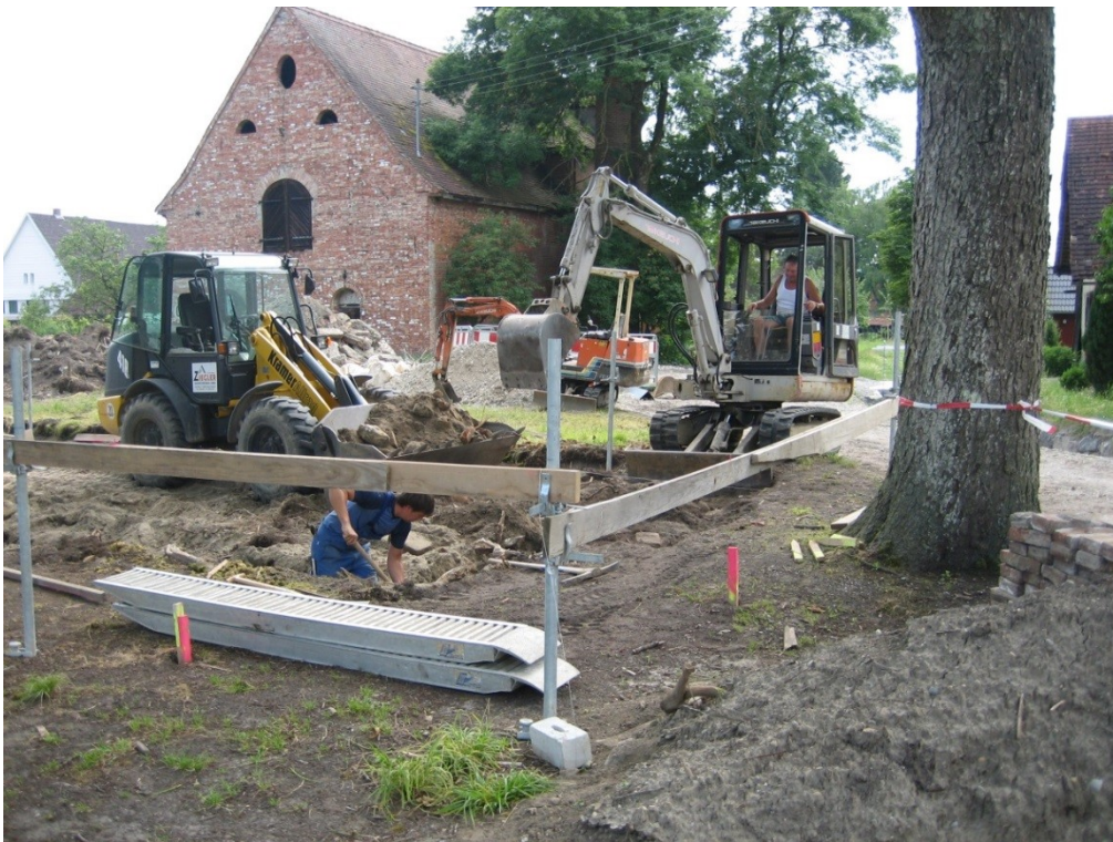
Abbildung 12: Die Kegelbahn bekommt ein neues Fundament (Juli 2010; im Vordergrund: Daniel Ziegler, Baggerführer: Franz Ziegler).
