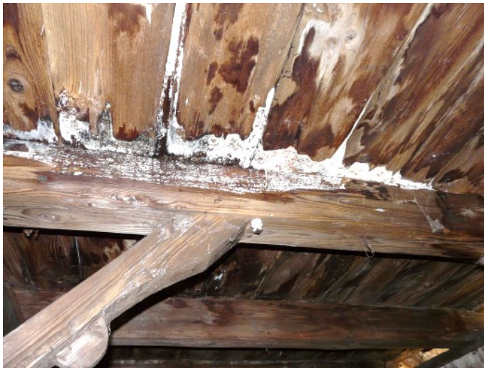
Abbildung 7: Der Wassereintrich durch das undichte Dach zeigt seine folgenschweren Spuren in der Kegelbahn (Bildaufnahme: Spätherbst 2009)
