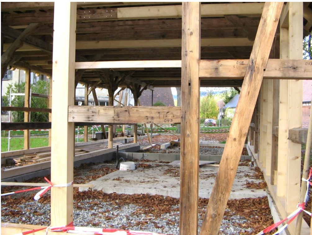
Abbildung 14: Mit neuen und ausgebesserten alten Bauteilen entsteht die Kegelbahn wieder (Oktober 2010)
