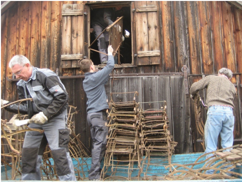
Abbildung 9: Entrümpelung der Kegelbahn im März 2010.
