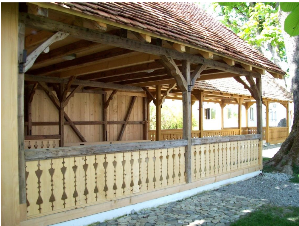
Abbildung 16: April 2011: Die neu errichtete und sanierte Kegelbahn wartet auf ihre Inbetriebnahme, die zur Eröffnung des erstmals auf dem neuen Dorfplatz stattfindenden Weildorfer Gassenfestes (03. bis 05.06.2011) mit einer feierlichen Übergabe an die Dorfgemeinschaft stattfand.
