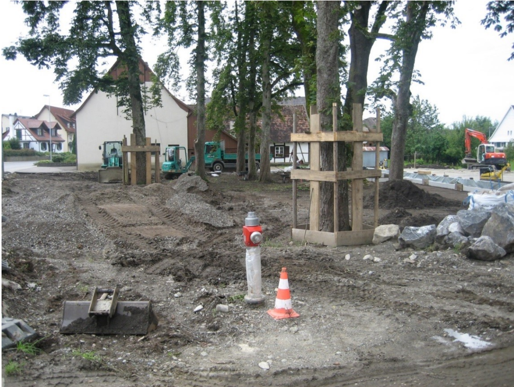
Abbildung 13: Auch der Adlergarten wird neugestaltet (August 2010). Im Hintergrund rechts das bereits fertig gestellte neue Fundament für die Kegelbahn
