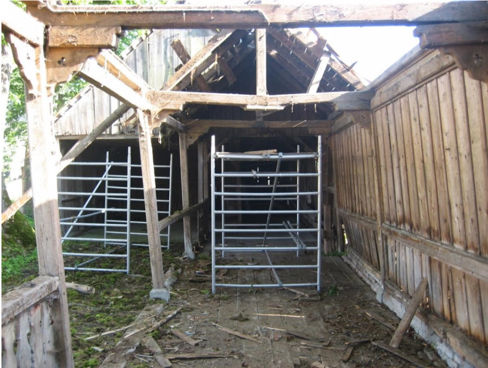
Abbildung 11: Abbrucharbeiten im Juni 2010 (Blick aus der Trinkhalle auf die Kegelbahn), die angesichts des Bauzustandes noch einmal die Dringlichkeit der Sanierungsmaßnahmen verdeutlichen.
